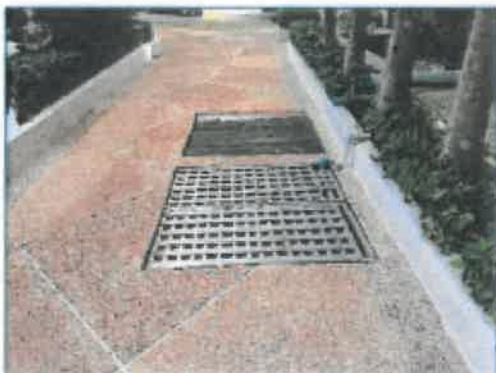
บ่อรับน้ำฝนเพื่อนำไปเติมสระว่ายน้ำ (บน) บ่อรับน้ำฝนเพื่อระบายออกสาธารณะ (ล่าง)
