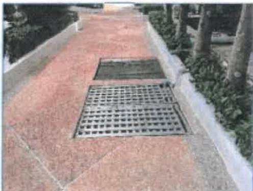
บ่อรับน้ำฝนเพื่อนำไปเติมสระว่ายน้ำ (บน) บ่อรับน้ำฝนเพื่อระบายออกสู่สาธารณะ (ล่าง)
