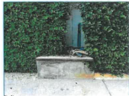
ชุดปรับปรุงคุณภาพน้ำทิ้งโดยคลอรีนและบ่อพักน้ำทิ้งสุดท้ายก่อนระบายออกสู่สาธารณะ
