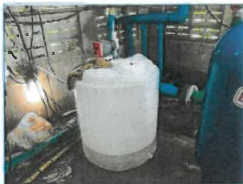
ชุดปรับปรุงคุณภาพน้ำทิ้งโดยคลอรีนและบ่อพักน้ำทิ้งสุดท้ายก่อนระบายออกสู่สาธารณะ
